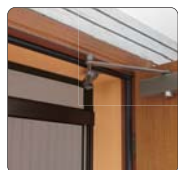
「高さ調整材」 で高さ調整
