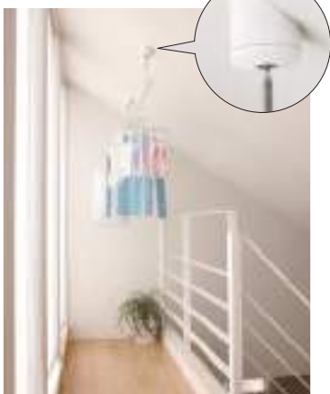
6寸勾配天井への施工例
